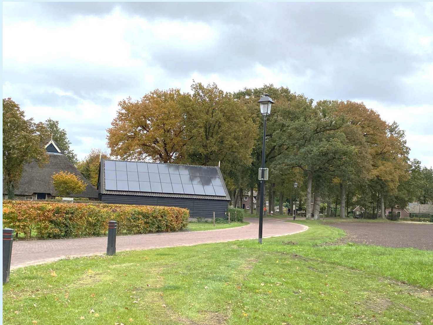
Zon op dak in beschermd gezicht.
